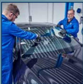
**2** Es empfiehlt sich, die neue Glasscheibe vor dem Reinigen auf Passgenauigkeit und Defekte zu prüfen. Anschließend die Distanzhalter einsetzen und die korrekte Position der Scheibe mit einem Klebeband markieren.
